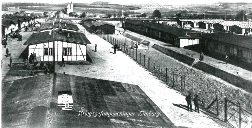
Gesamtansicht der Lageranlage mit Blick auf die Lubentiuskirche
